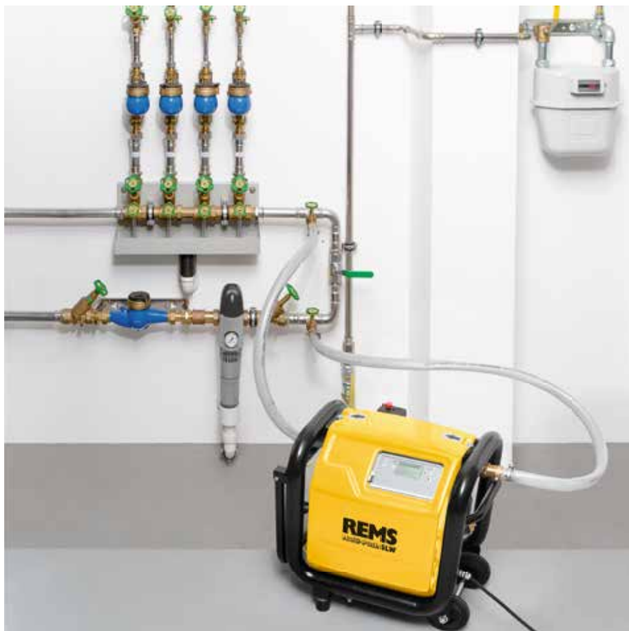
Flussaggio di impianti di acqua potabile
